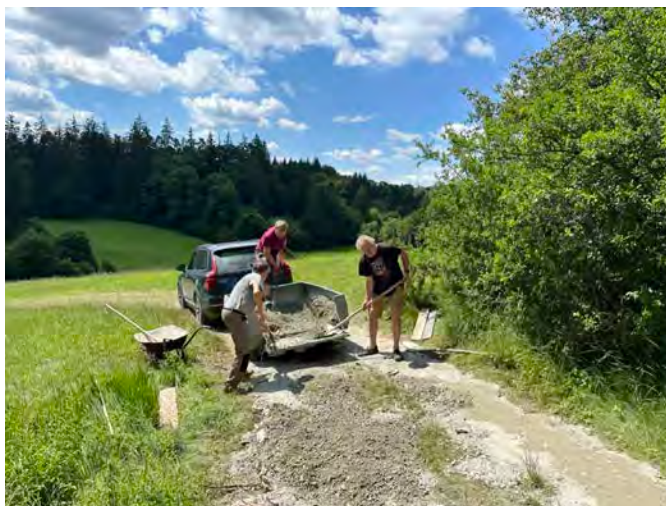
Oprava příjezdové cesty na základnu (Foto: J. Sirotek)
